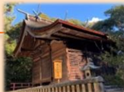
国重要文化財 『桂濱神社 本殿』
